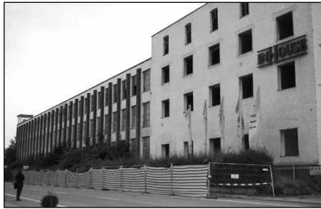
Ein "letzter Blick" auf die ehemalige Firma "Kabjoll". Mit dem Abriss verschwindet ein Stück unserer Geschichte für immer.
