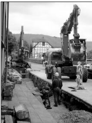
Schweres Gerät wird eingesetzt, um die Kanalarbeiten zügig zu erledigen.
